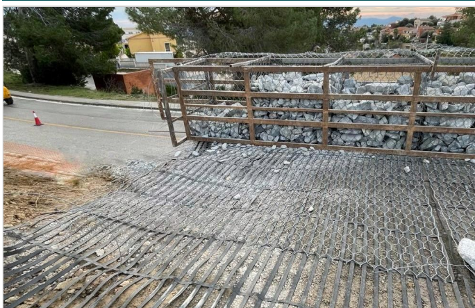
Refuerzo híbrido con cola metálica y ParaGrid
