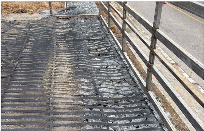
Colocación de la geomalla ParaGrid
