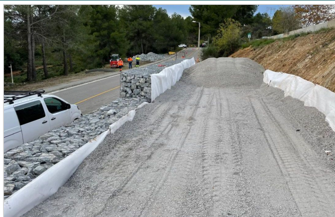
Relleno del trasdós con material seleccionado
