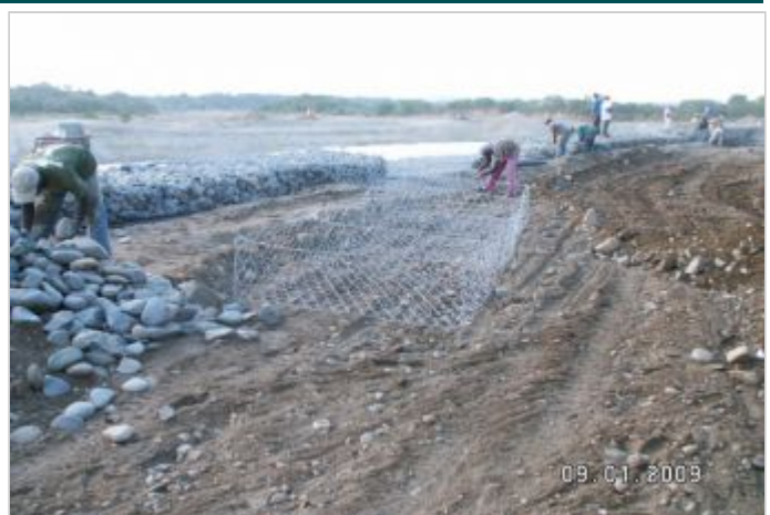
Durante la Obra
