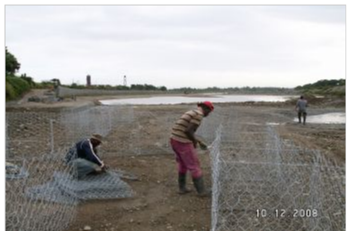
Durante la Obra
