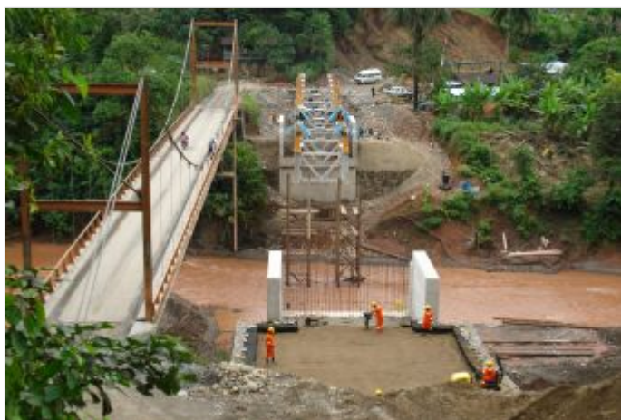
Durante a obra
