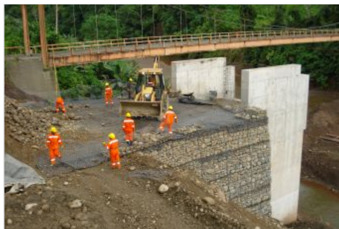
Durante a obra
