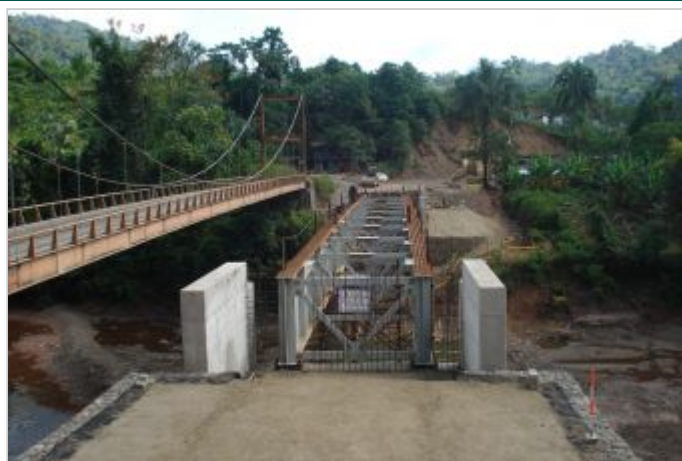
Durante a obra
