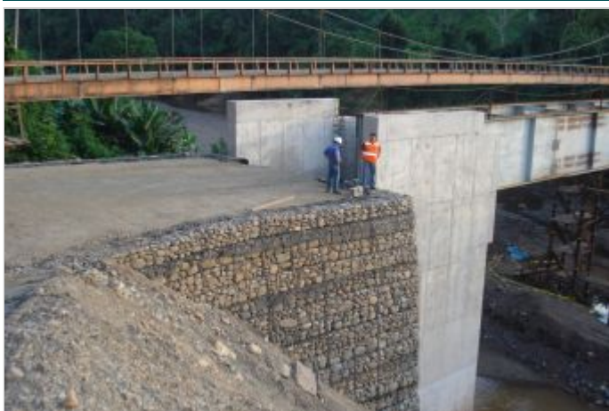
Durante a obra
