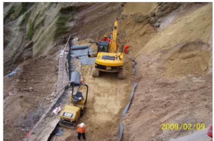
Durante la Obra
