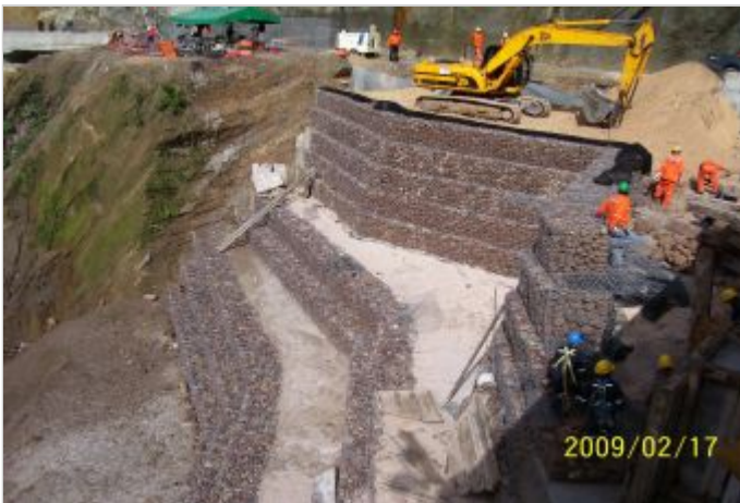
Durante la Obra
