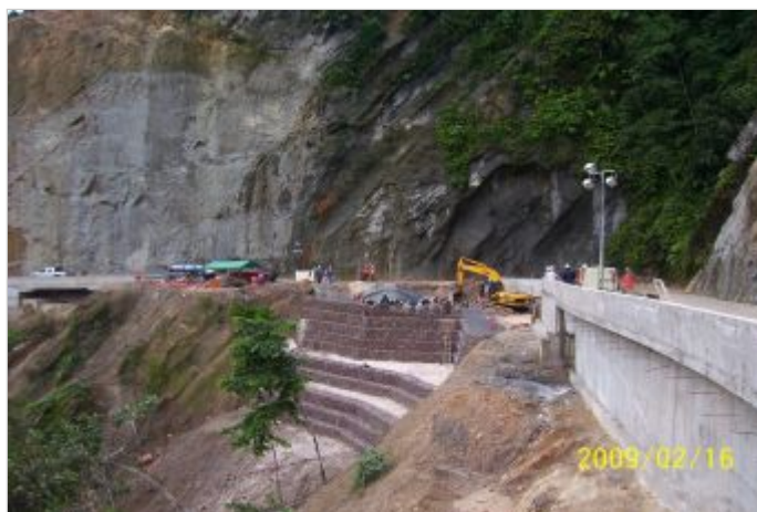
Durante la Obra
