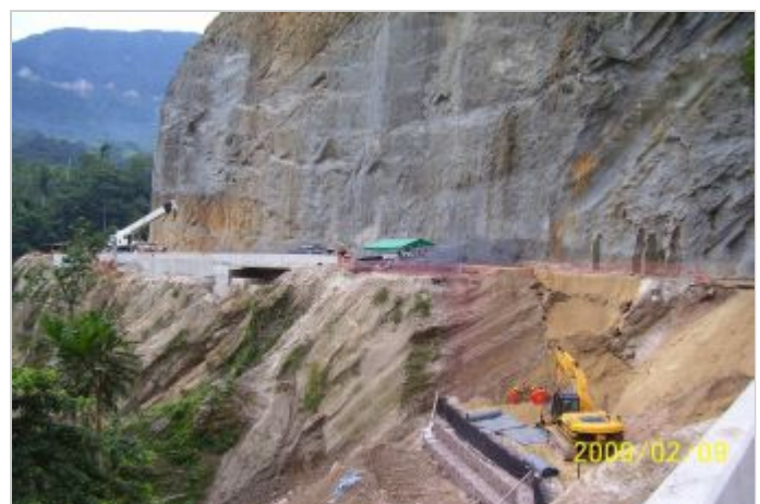
Durante la Obra
