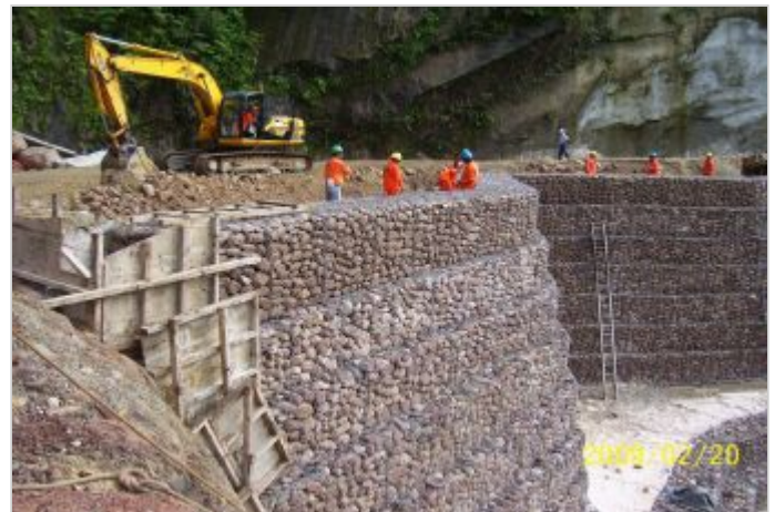
Durante la Obra
