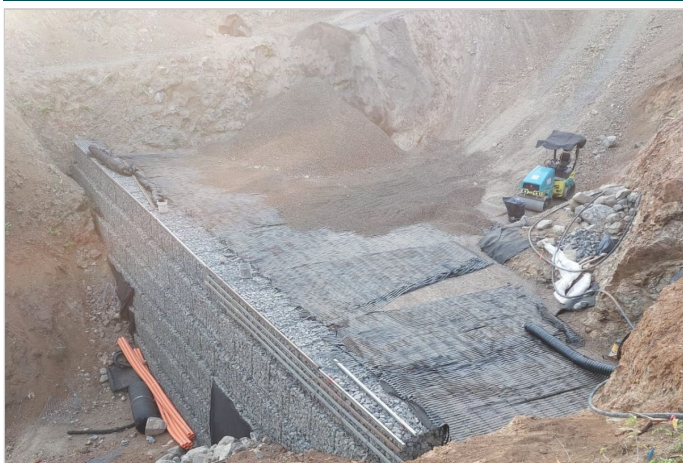
Durante la Obra
