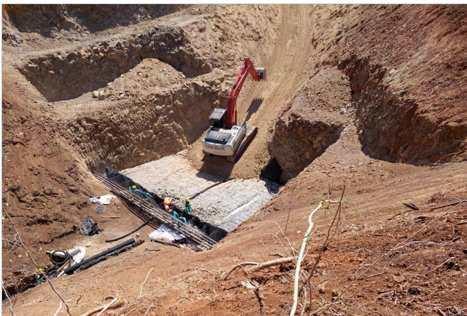
Durante la Obra
