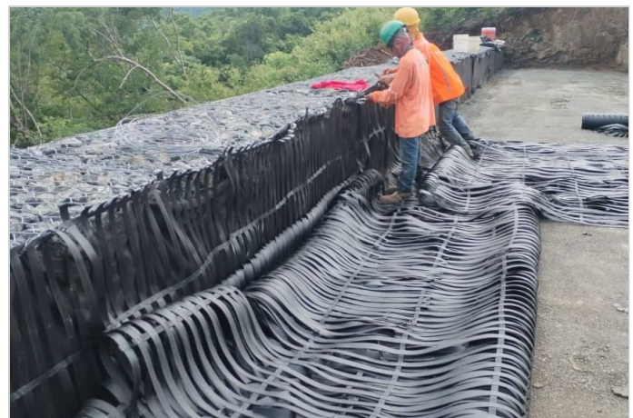
Durante la Obra
