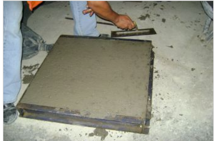
Durante a obra
