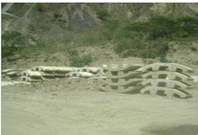
Durante a obra
