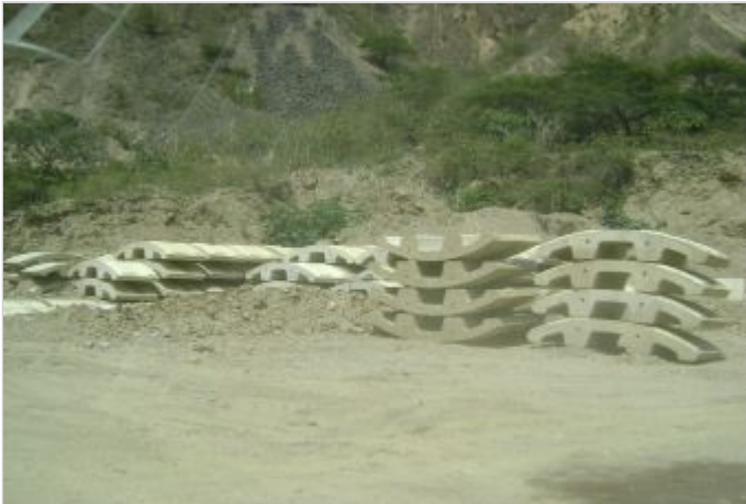
Durante a obra
