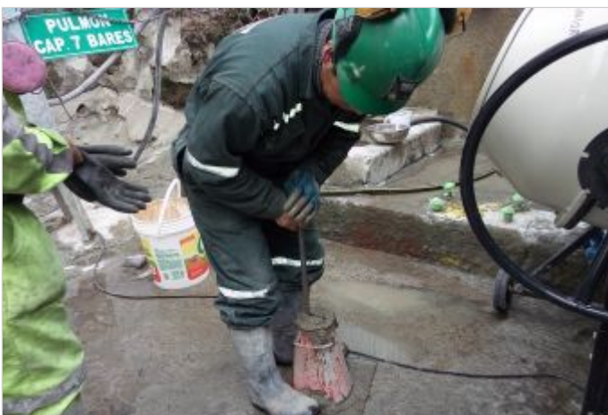
Durante a obra
