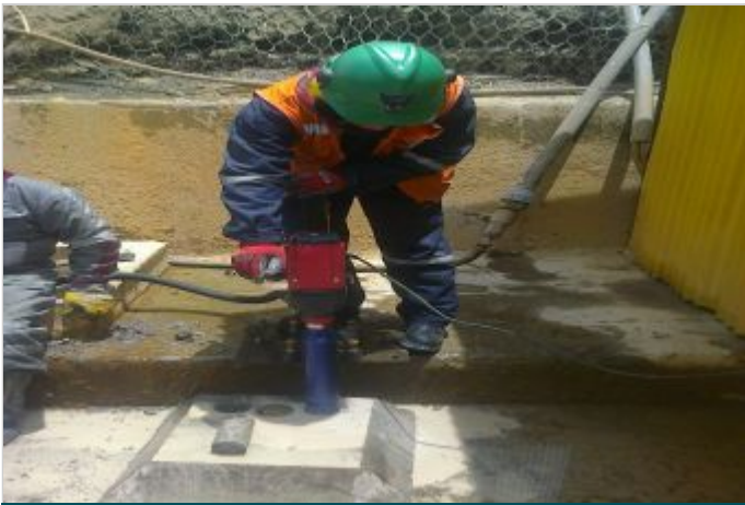
Durante a obra
