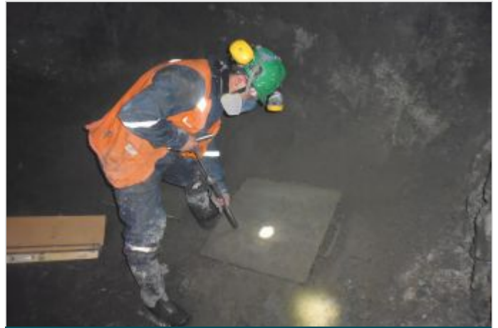
Durante a obra
