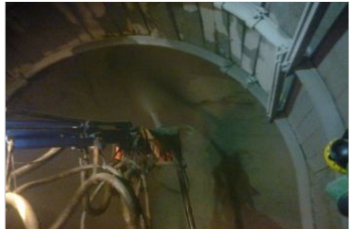
Durante a obra
