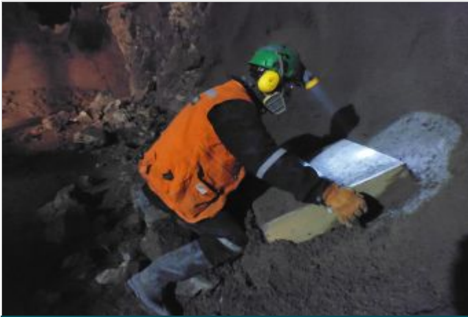
Durante a obra
