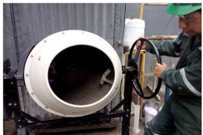
Durante a obra
