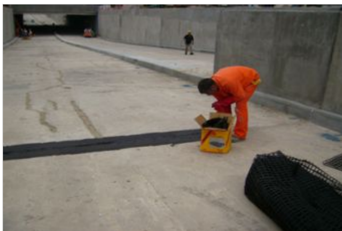
Durante a obra
