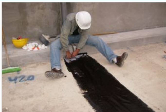
Durante a obra
