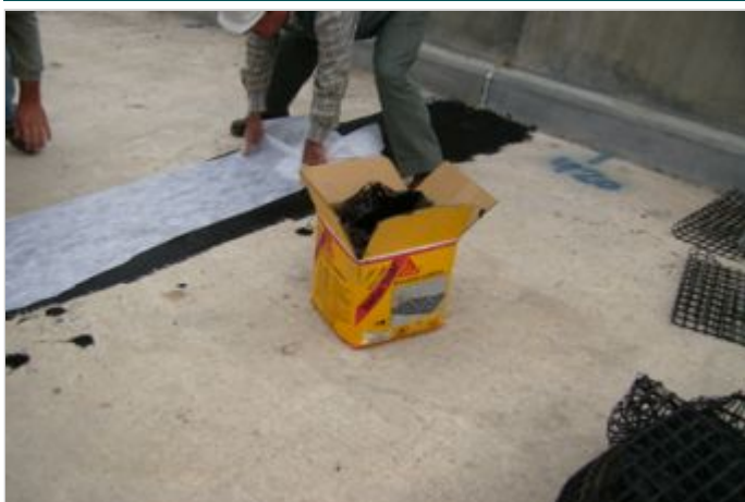
Durante a obra
