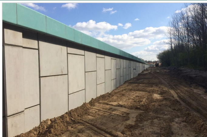
Ukończony fragment ściany oporowej
