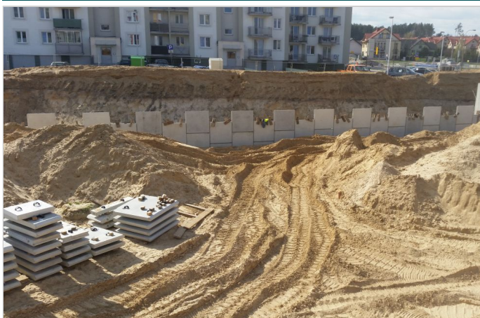
Pierwsze rzędy paneli ściany oporowej w technologii MacRes
