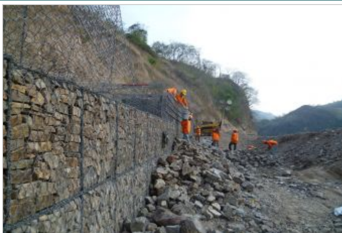
Durante la Obra
