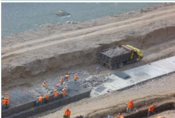
Durante la Obra
