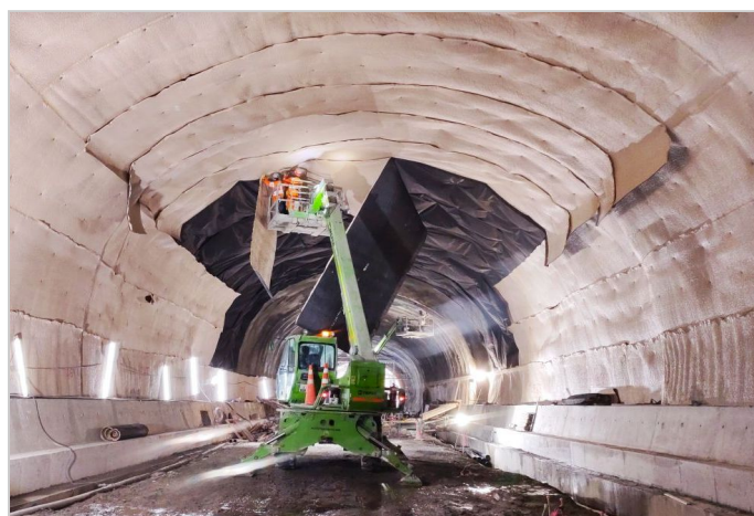
Durante la Obra
