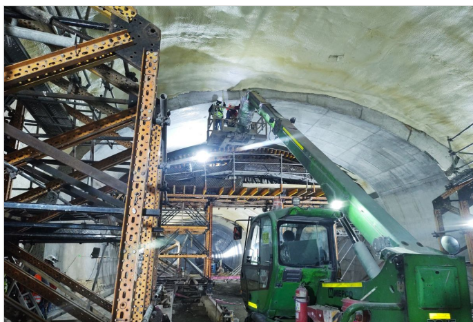
Durante la Obra
