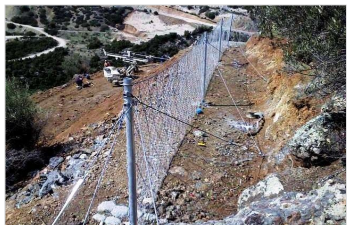
ΦΡΑΚΤΗΣ CTR 02/09/B ΣΤΗ ΦΑΣΗ ΤΗΣ ΚΑΤΑΣΚΕΥΗΣ
