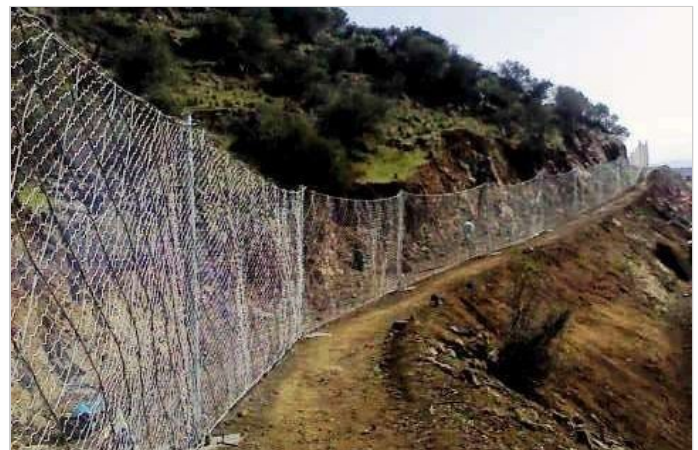
ΦΡΑΚΤΗΣ ΑΝΑΣΧΕΣΗΣ ΒΡΑΧΟΠΤΩΣΕΩΝ CTR F2/09/B
