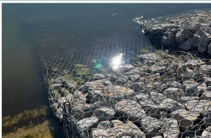
RenoMac Plus recouvert de Matelas Reno Plus
