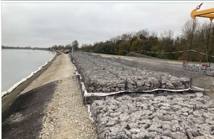
Palonnier en cours de levage des RenoMac Plus
