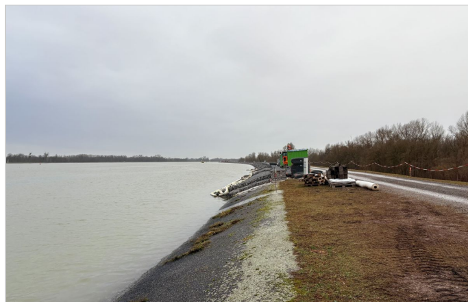
Solution en cours de pose
