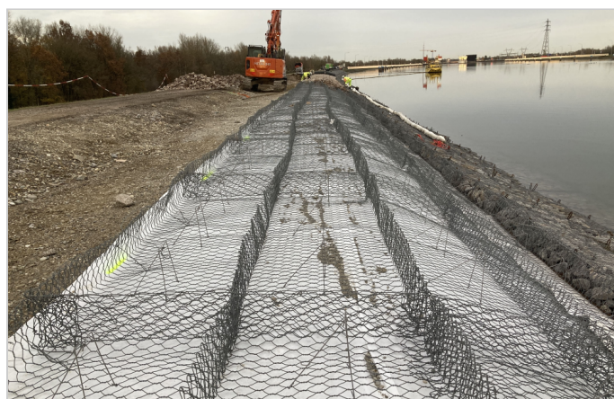
Matelas Reno Plus prêts à être remplis de pierres à gabions
