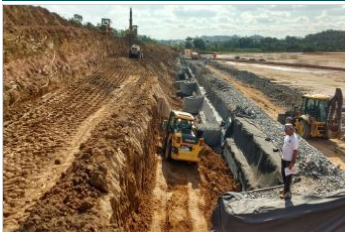
Durante a obra
