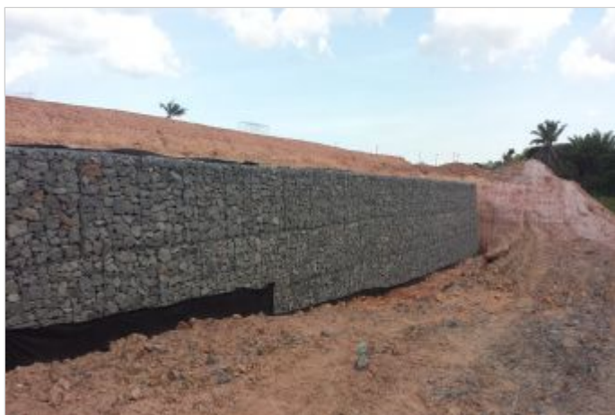
Durante a obra
