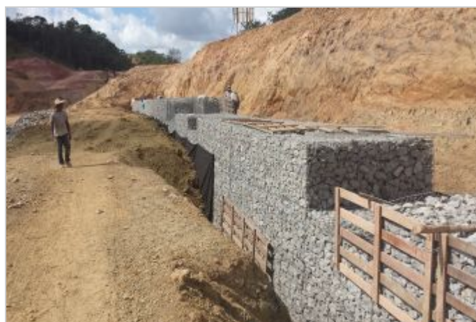
Durante a obra
