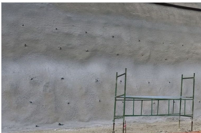
ΑΓΚΥΡΙΑ 500/550, ολοκλήρωση τοποθέτησης
