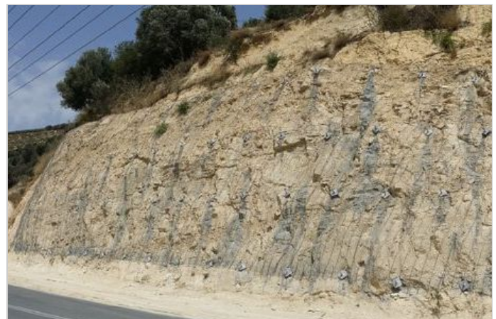
Απρίλιος 2016 : STEELGRID HR, μετά τη τοποθέτηση
