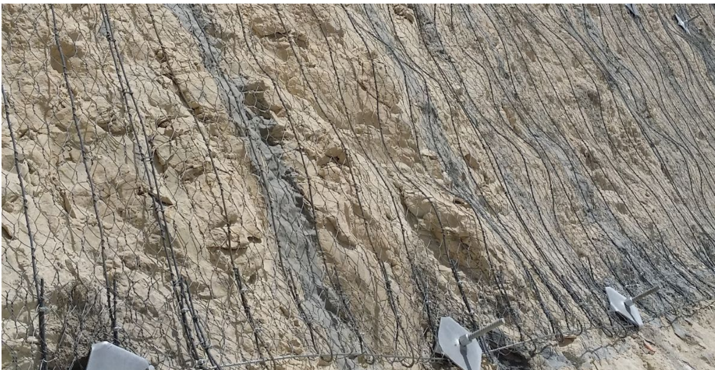
STEELGRID HR-30 μετά τη τοποθέτηση
