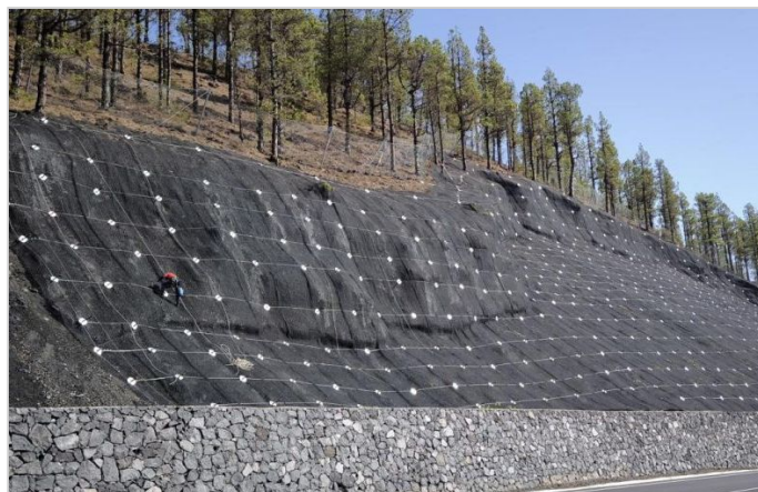
Instalación de la MacMat HS 30 vista desde la vía
