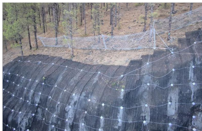
Instalación de la MacMat HS 30 y la barrera RB 750
