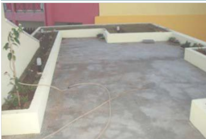
Durante a obra
