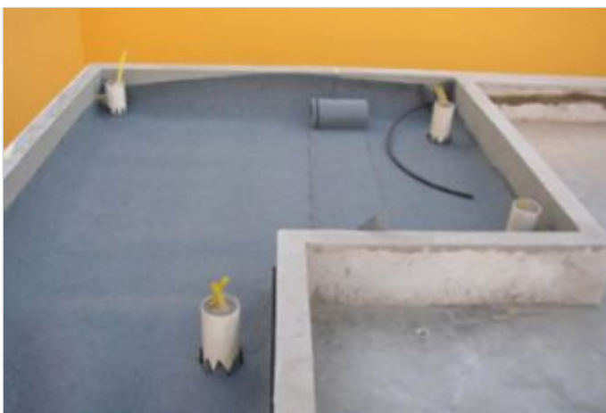
Durante a obra
