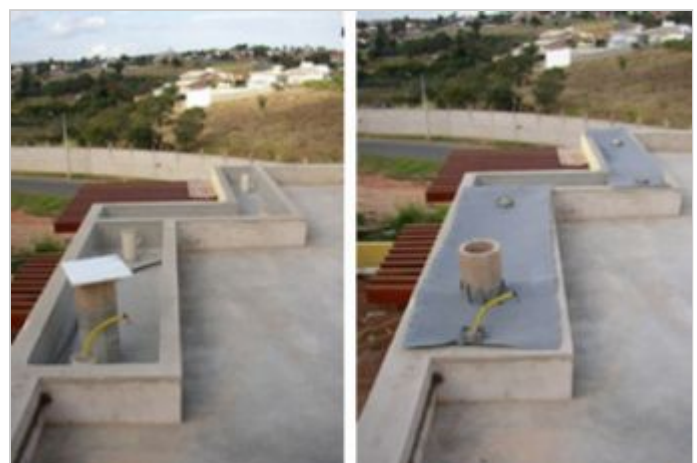
Durante a obra
