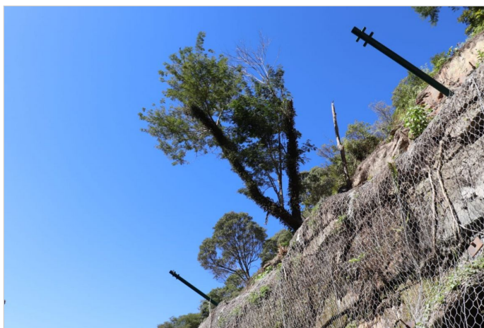
Durante a obra
