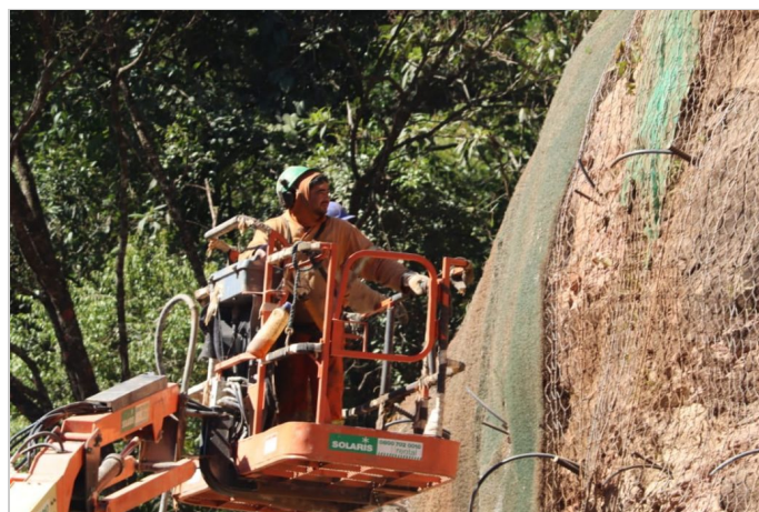
Durante a obra
