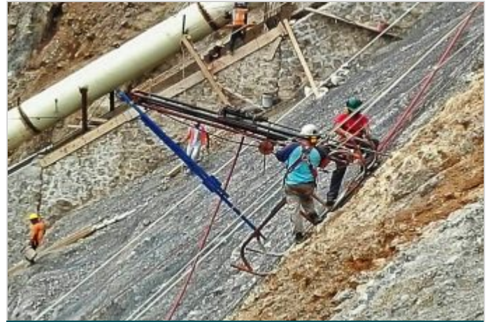
Durante la Obra
