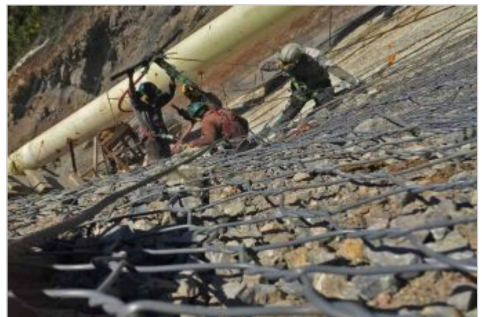
Durante la Obra
