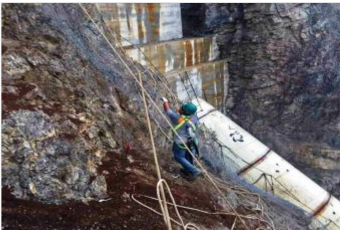
Durante la Obra
