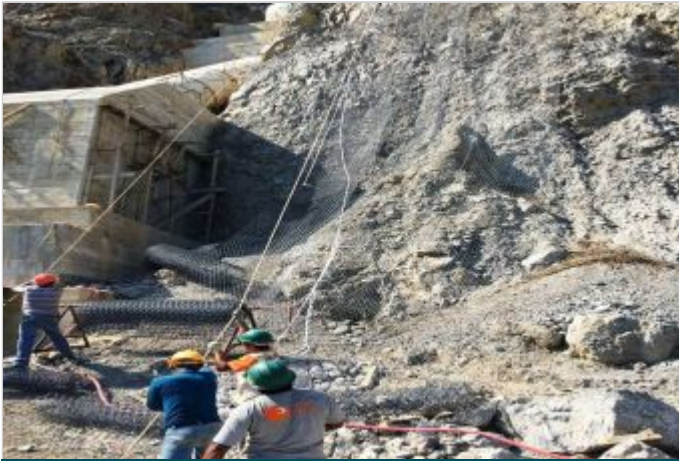
Durante la Obra
