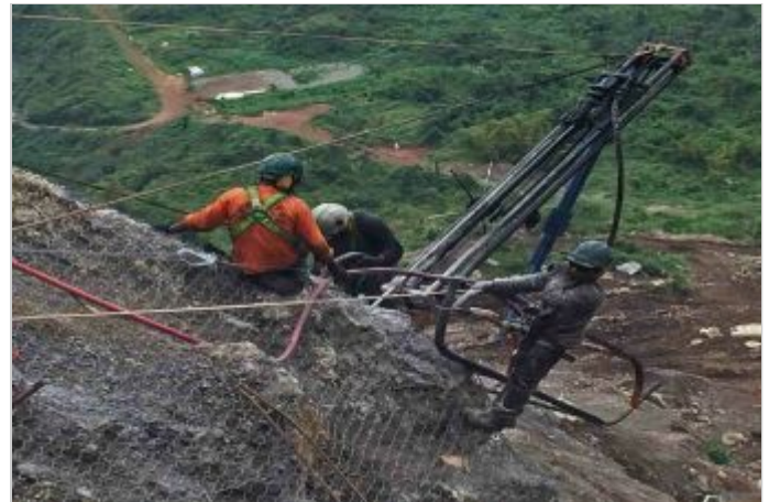
Durante la Obra
