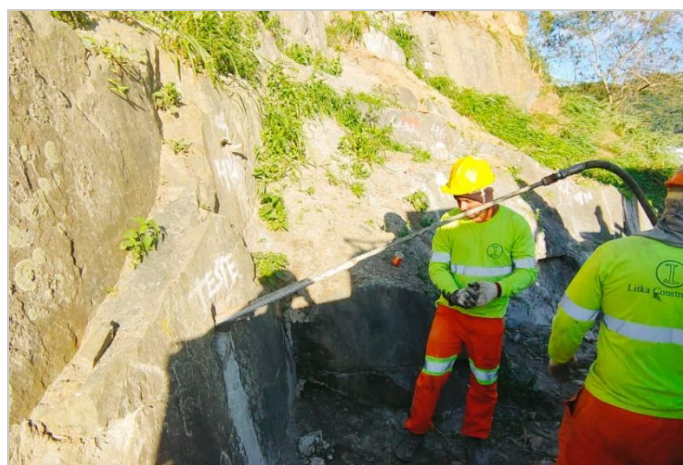
Durante a obra
