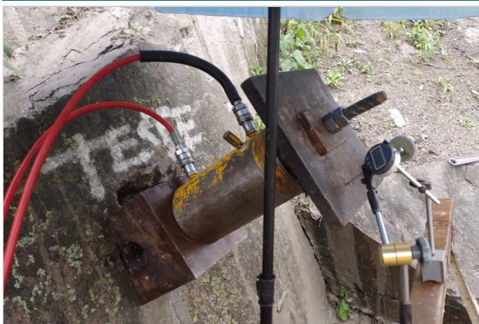
Durante a obra
