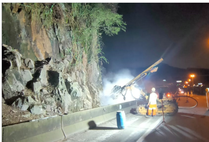
Durante a obra
