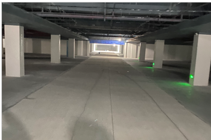
图4 找平层浇筑完成
