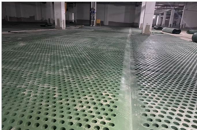
图2 排水板铺设施工
