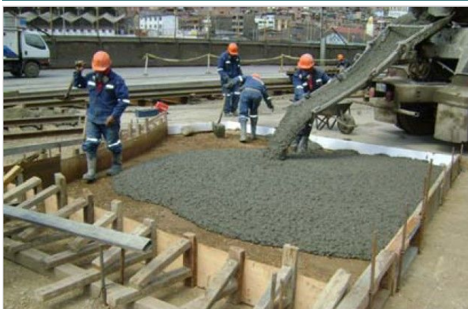
Vaciado de concreto con fibras
