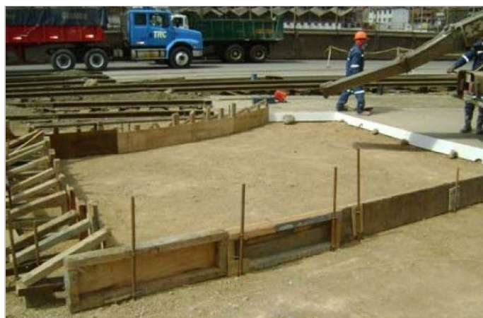
Antes del vaciado
