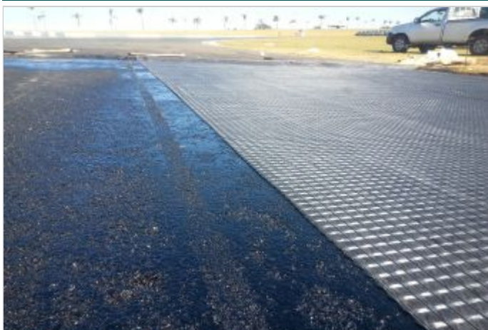
Durante la Obra
