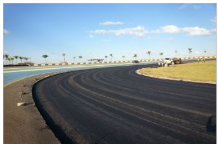
Durante la Obra
