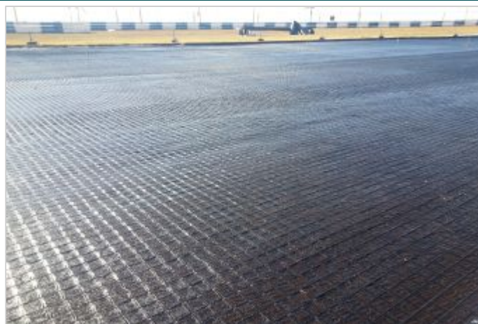
Durante la Obra
