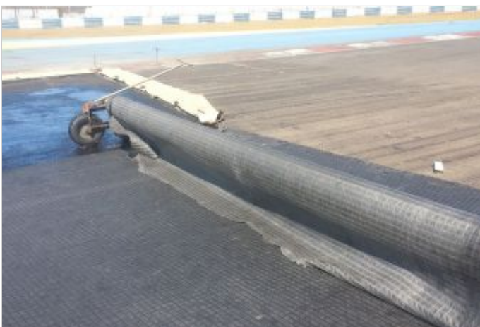
Durante la Obra
