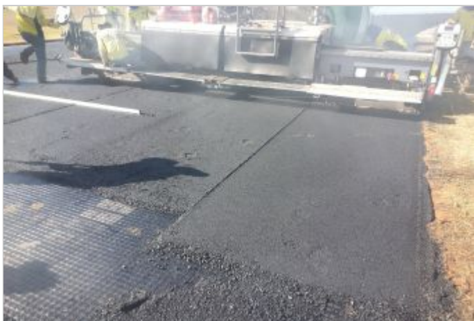
Durante la Obra
