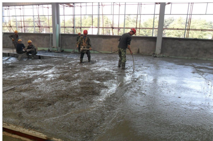
施工地坪情况
