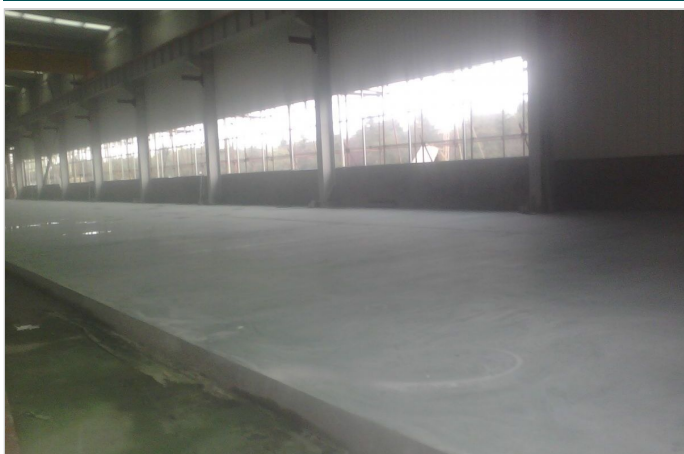
地坪板实拍场景1
