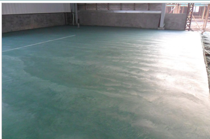
地坪板实拍场景2
