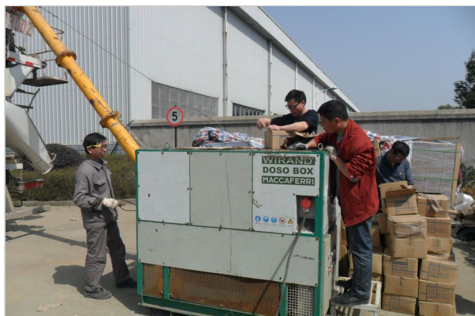
施工现场DOSO吹喷机添加
