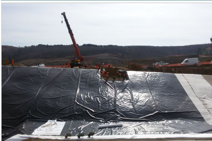
ΕΡΓΑΣΙΕΣ ΤΟΠΟΘΕΤΗΣΗΣ ΤΗΣ ΓΕΩΜΕΜΒΡΑΝΗΣ MACLINE SDH 200
