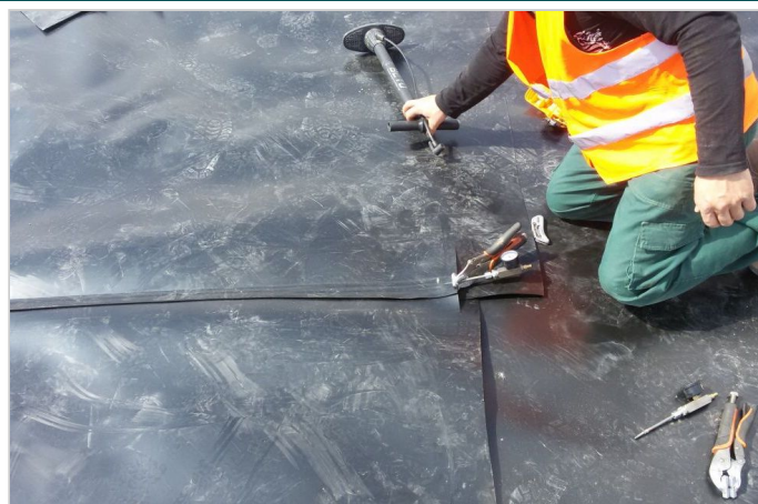
ΕΡΓΑΣΙΕΣ ΣΥΓΚΟΛΛΗΣΗΣ ΓΕΩΜΕΜΒΡΑΝΩΝ MACLINE SDH
