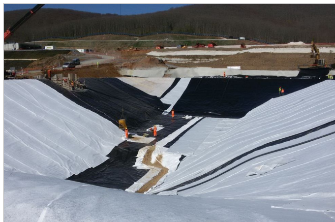
ΕΙΚΟΝΑ ΤΩΝ ΠΡΑΝΩΝ ΤΗΣ ΛΙΜΝΟΔΕΞΑΜΕΝΗΣ ΚΑΤΑ ΤΗΣ ΤΟΠΟΘΕΤΗΣΗΣ ΤΟΥ MACDRAIN W 1051
