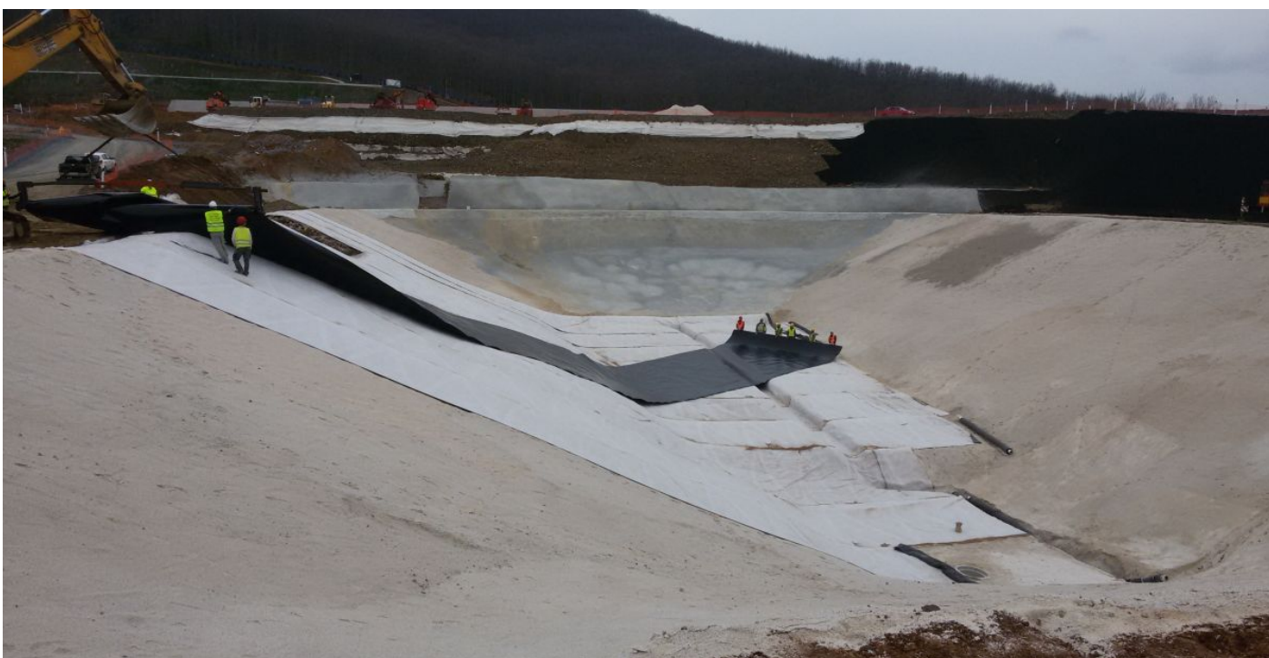
ΓΕΝΙΚΗ ΕΙΚΟΝΑ ΚΑΤΑ ΤΗ ΔΙΑΔΙΚΑΣΙΑ ΤΟΠΟΘΕΤΗΣΗΣ ΤΩΝ ΓΕΩΣΥΝΘΕΤΙΚΩΝ
