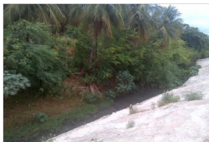
Antes da Obra
