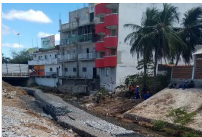
Durante a obra
