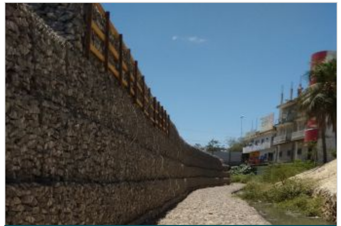
Durante a obra
