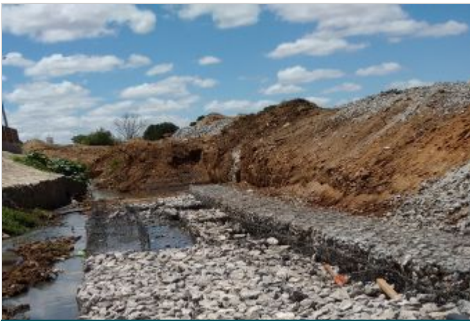
Durante a obra
