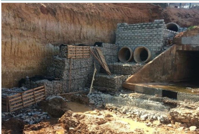
Durante la Obra
