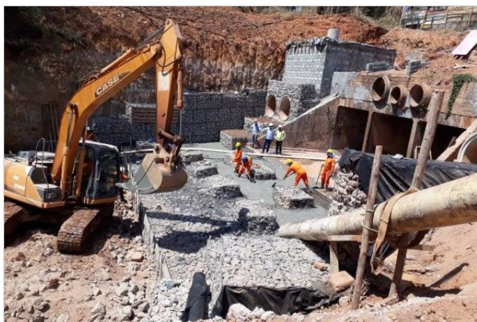
Durante la Obra
