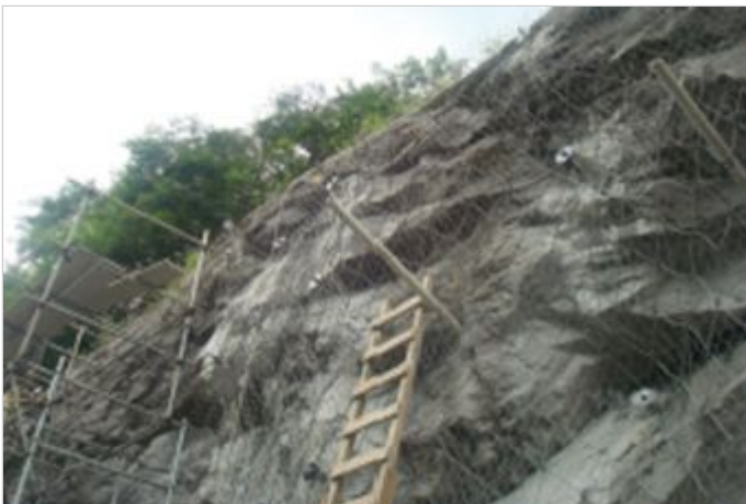
Durante la Obra
