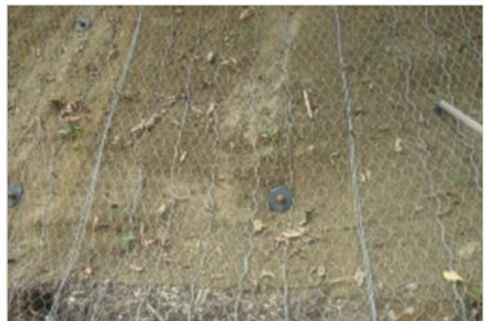
Durante la Obra
