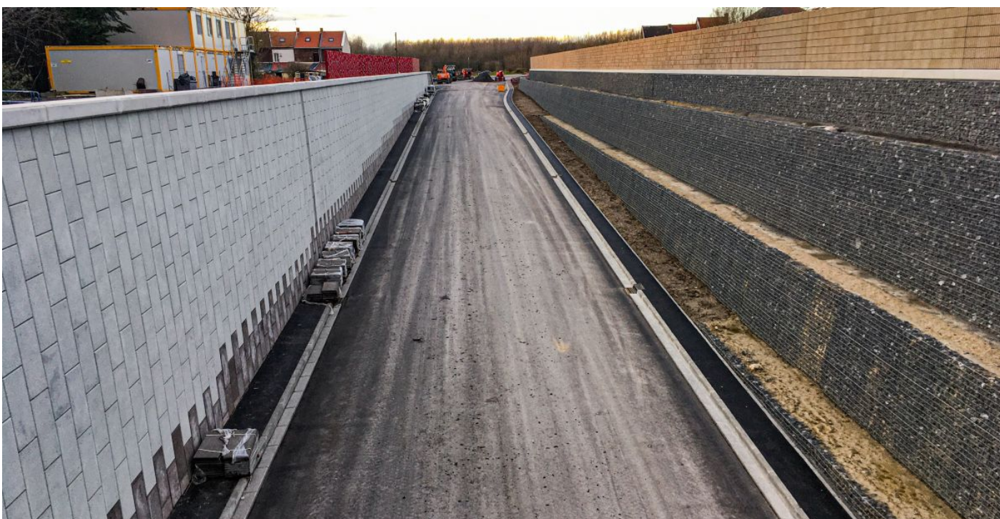
Terramesh minéral et habillage en gabions électrosoudés
