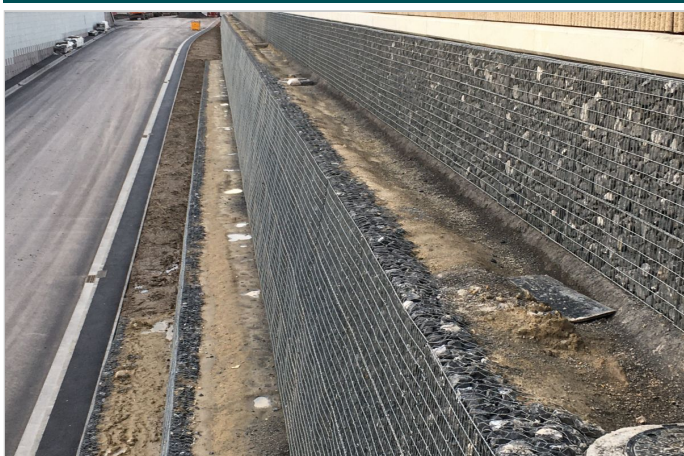
Terramesh minéral et habillage en gabions électrosoudés
