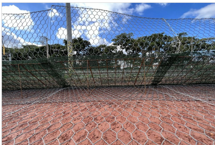
Durante a obra
