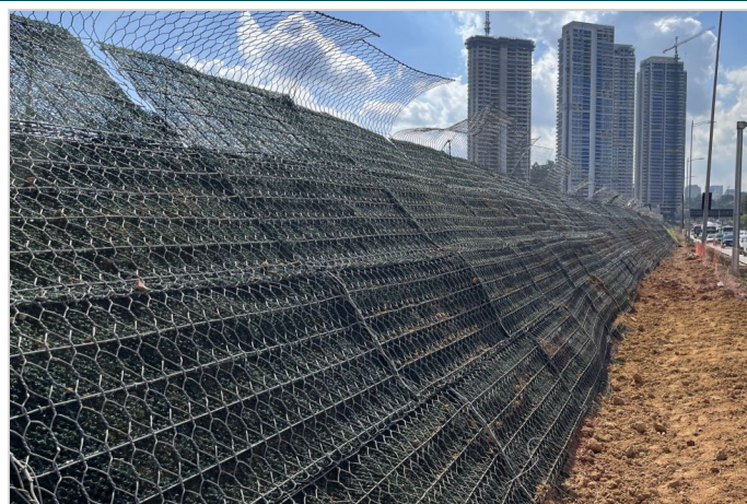
Durante a obra
