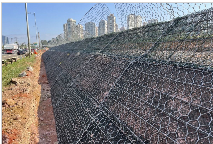
Durante a obra
