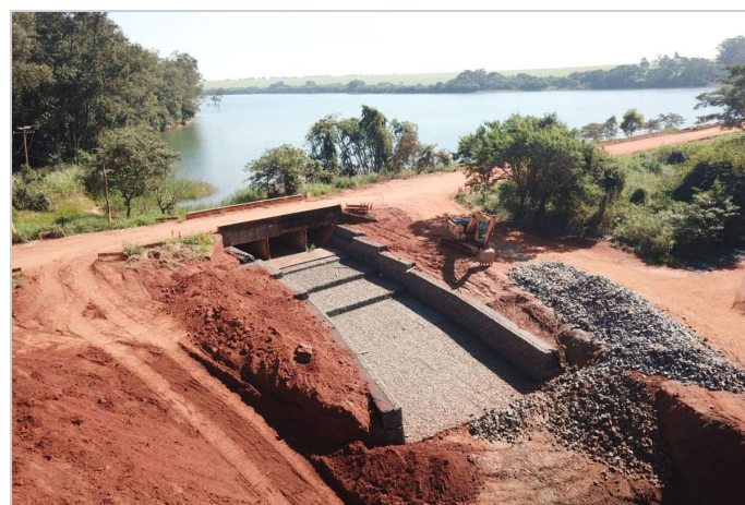
Durante a obra
