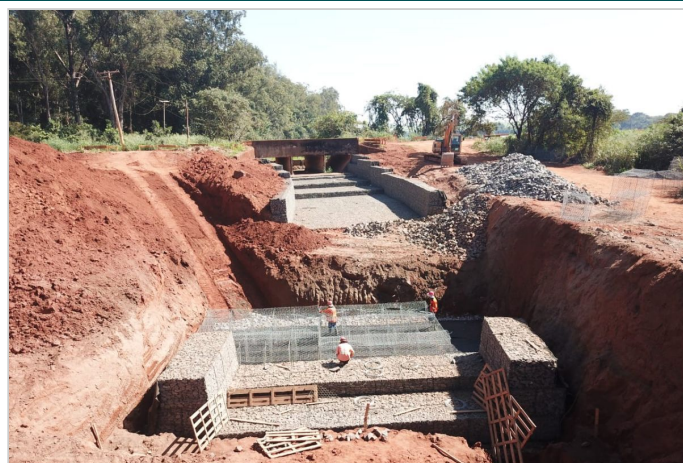
Durante a obra
