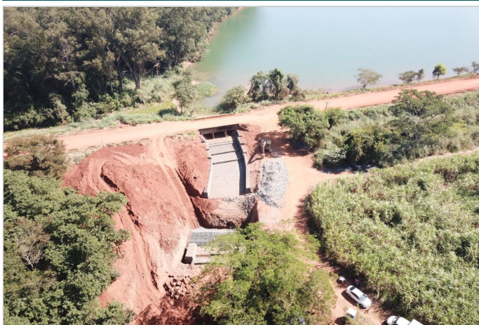
Durante a obra
