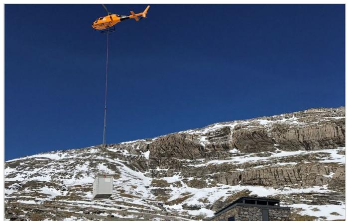
Instalación mallatas mediante helicóptero. Zona de difícil acceso
