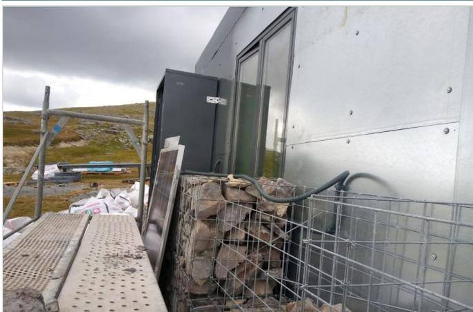
Proceso de instalación revestimiento de malla electrosoldada GAVIARQ
