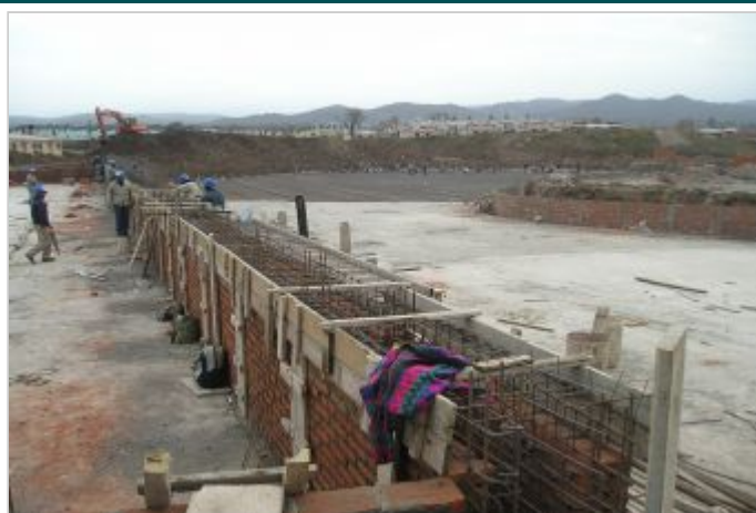
Durante la Obra
