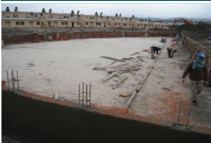
Durante la Obra
