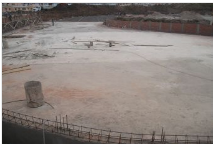
Durante la Obra
