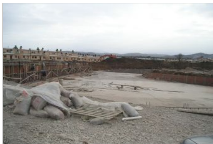
Durante la Obra
