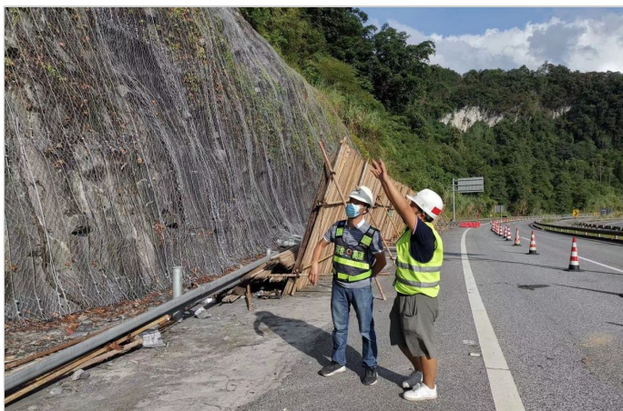
施工技术人员指导安装
