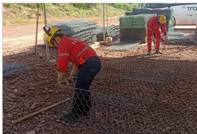
Durante a obra
