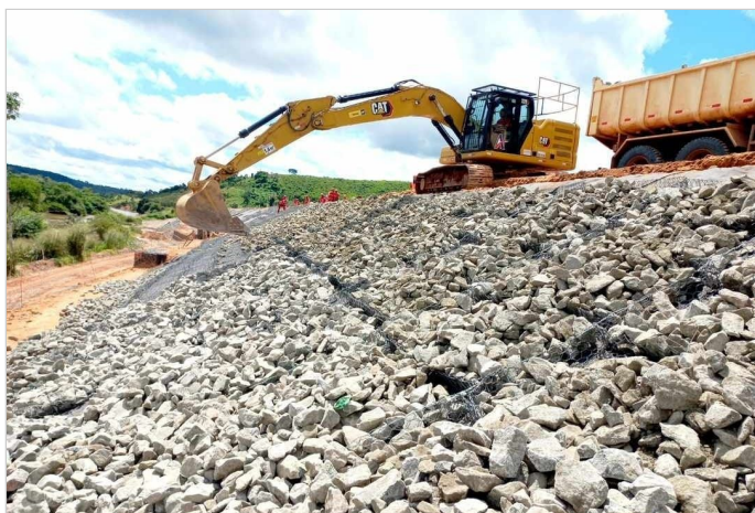
Durante a obra
