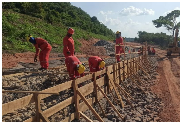
Durante a obra
