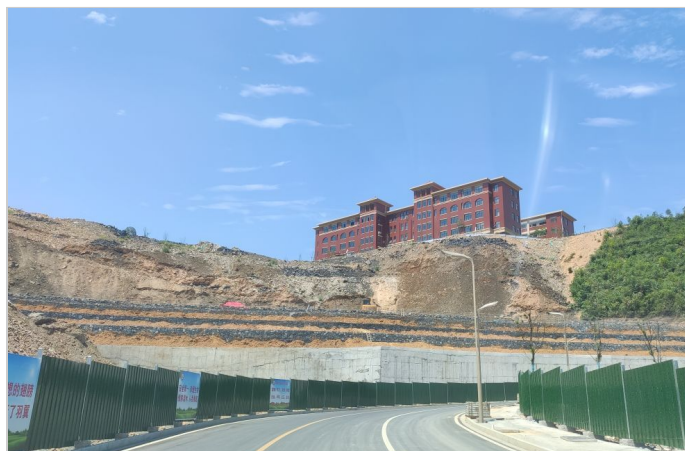
施工中远景照片
