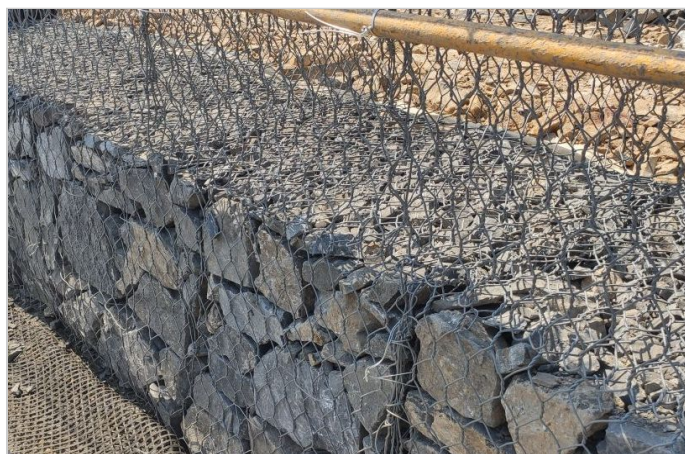
施工中照片：面墙施工
