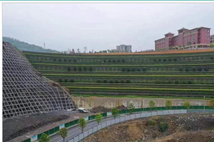
施工完成照片
