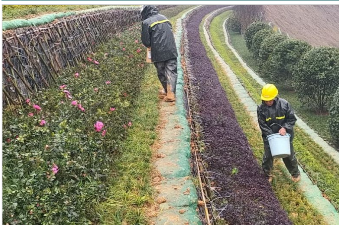
施工中照片:绿化养护
