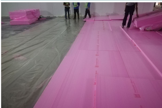
图3 冷链库房地面保温板铺设
