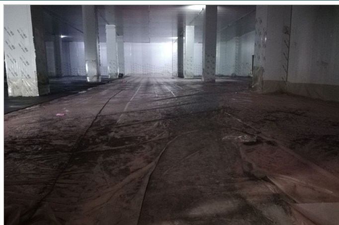
图4 冷链库房地面保温板保护砂浆浇筑
