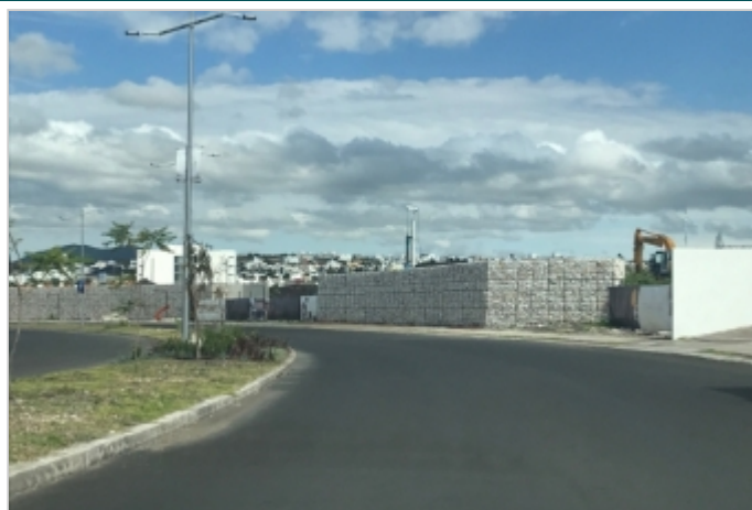
Durante a obra
