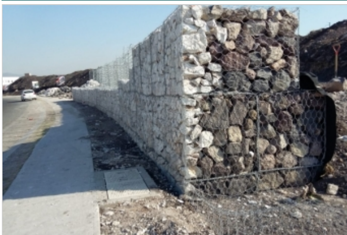
Durante a obra
