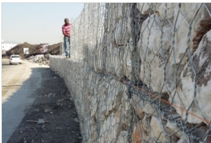
Durante a obra
