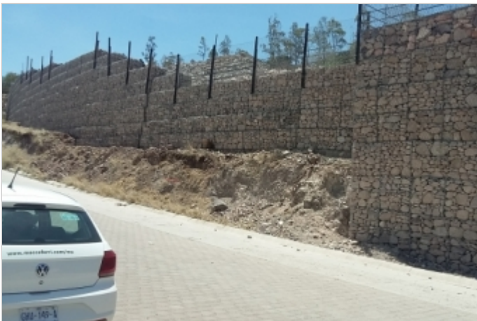
Durante la Obra
