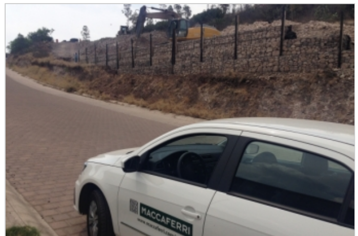
Durante la Obra
