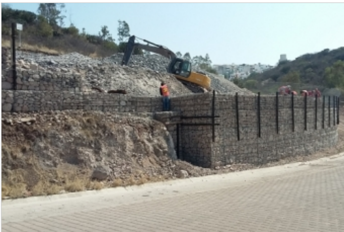
Durante la Obra
