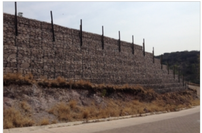
Durante la Obra
