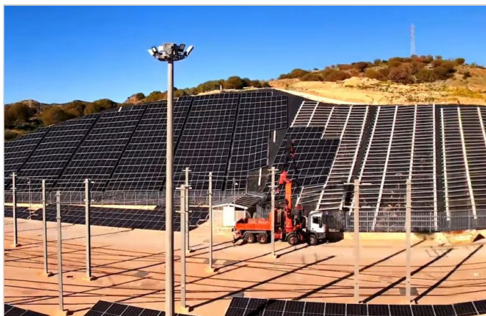
Proceso de instalación de los paneles solares en el talud
