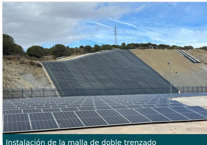
Instalación de la malla de doble trenzado
