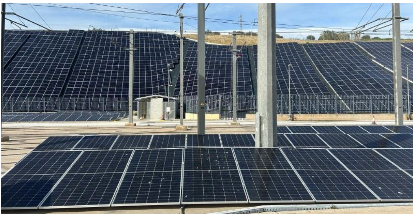
Culminación de la tercera fase de la planta solar fotovoltaica
