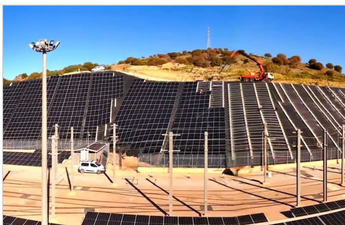
Avance de la instalación de los paneles solares
