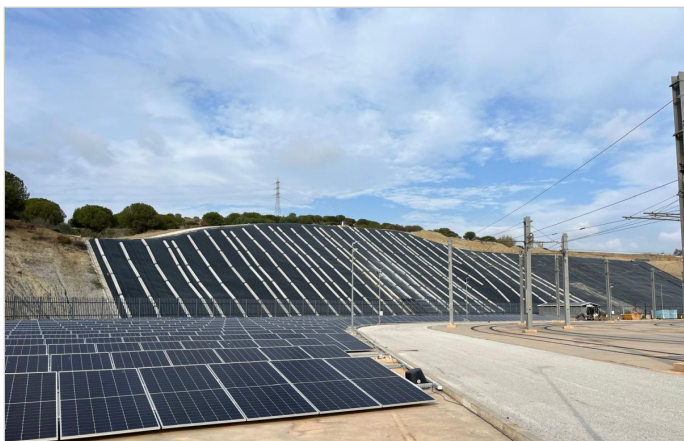
Instalación completa de la malla
