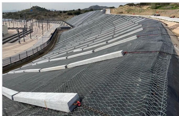
Vista en coronación durante el proceso constructivo
