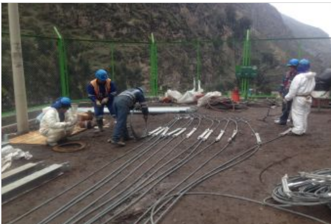
Durante la Obra
