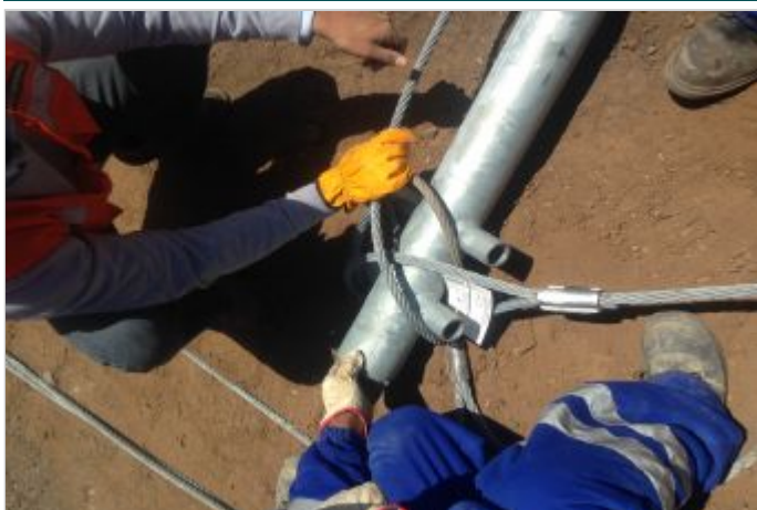
Durante la Obra
