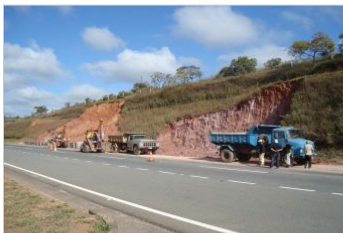
Durante la Obra
