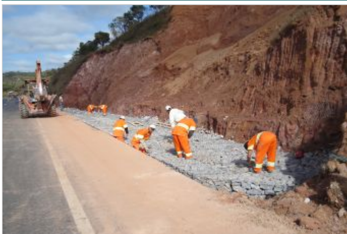
Durante la Obra
