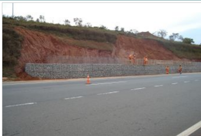
Durante la Obra
