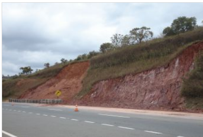
Durante la Obra
