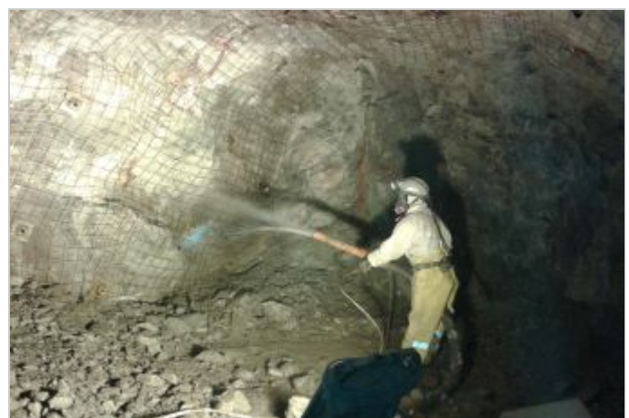
Durante la Obra
