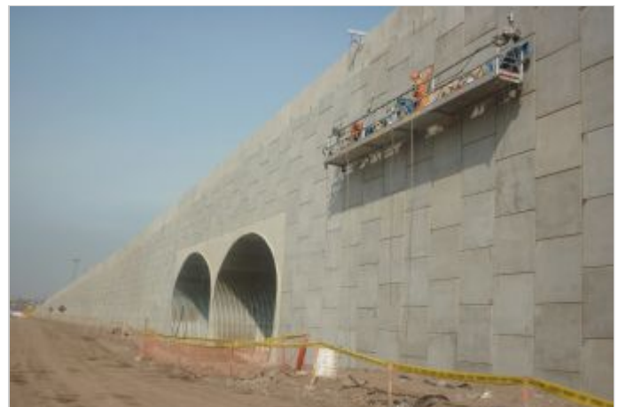
Durante la Obra
