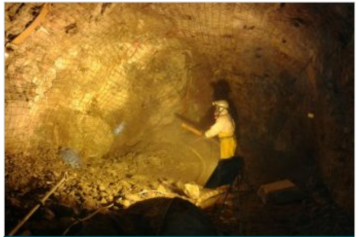
Durante la Obra
