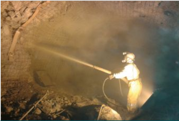
Durante la Obra
