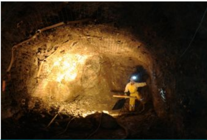
Durante la Obra
