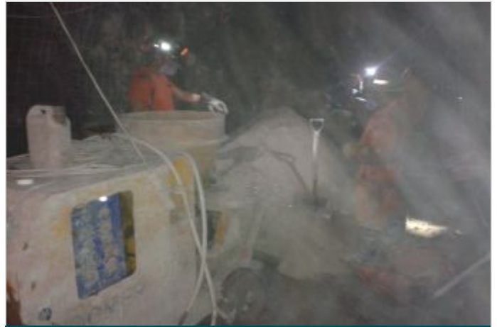
Durante la Obra
