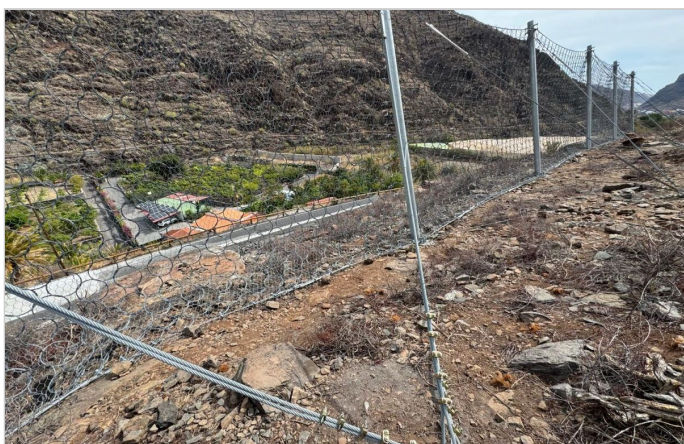
Viviendas protegidas por la barrera
