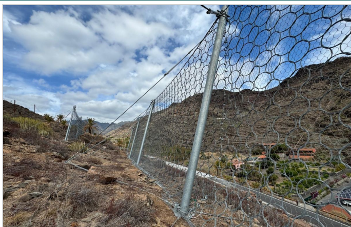
Vista de las barreras y la vía
