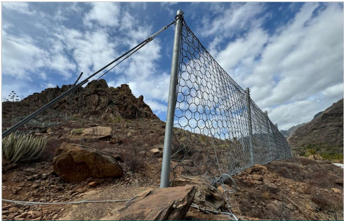
Vista de las barreras y la ladera
