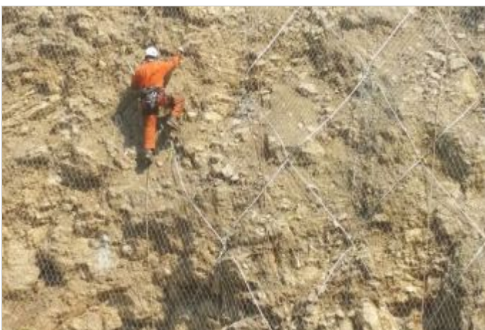
Durante la Obra
