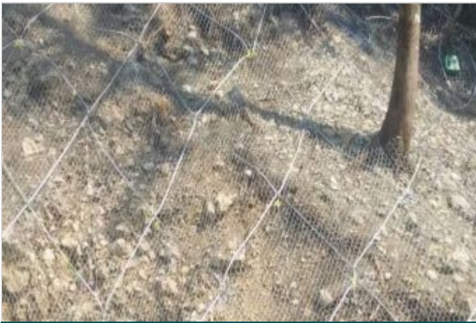
Durante la Obra
