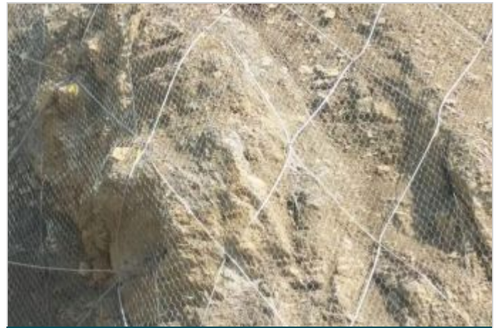
Durante la Obra
