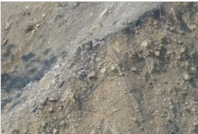
Durante la Obra
