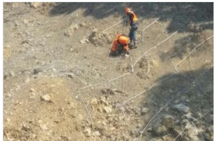
Durante la Obra
