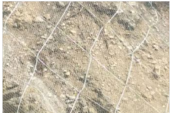
Durante la Obra
