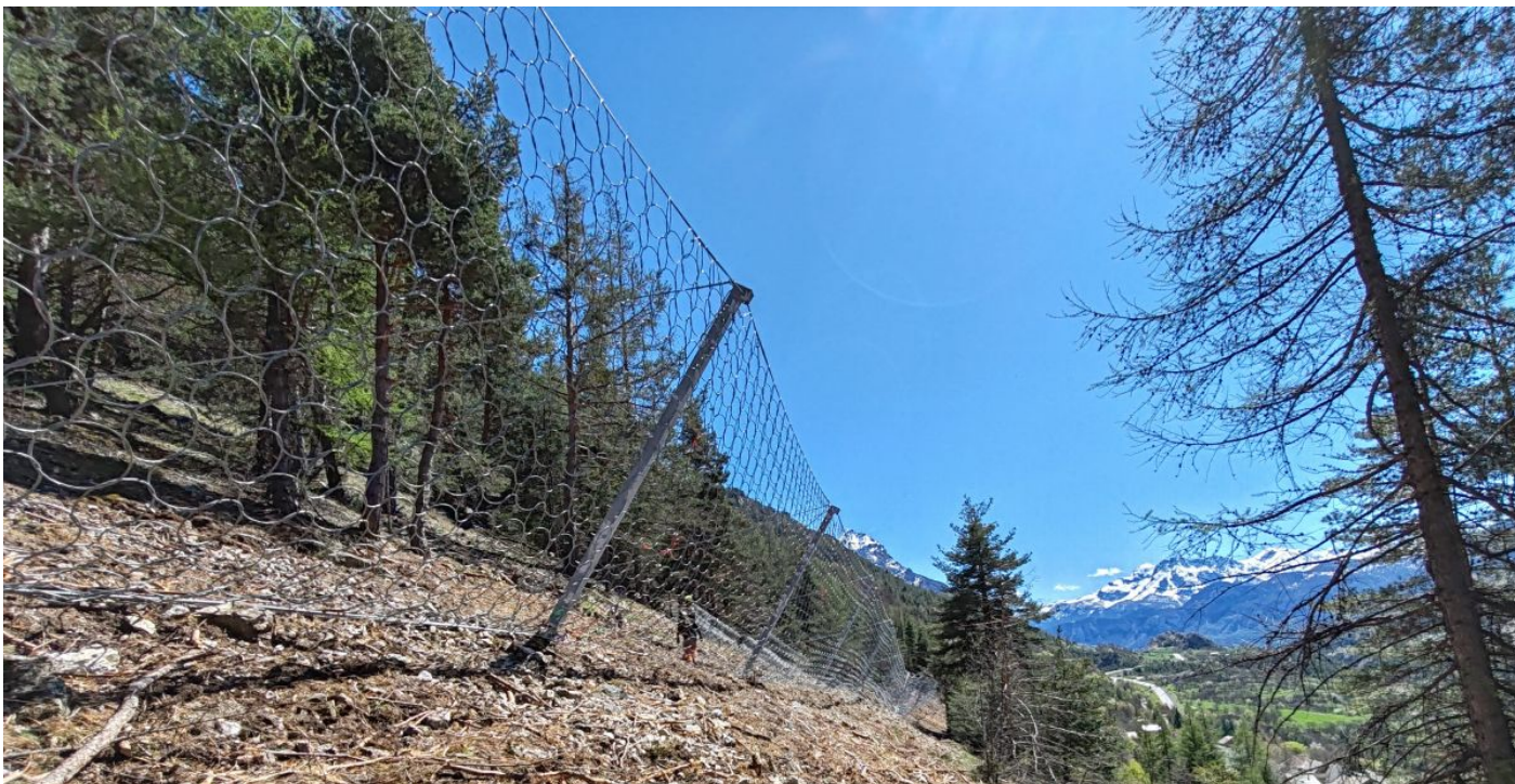
Vue d'une partie du chantier
