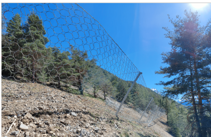
Barrière testée à 6m, certifiée CE jusqu'à 7m, selon l'EAD 340059-00-0106
