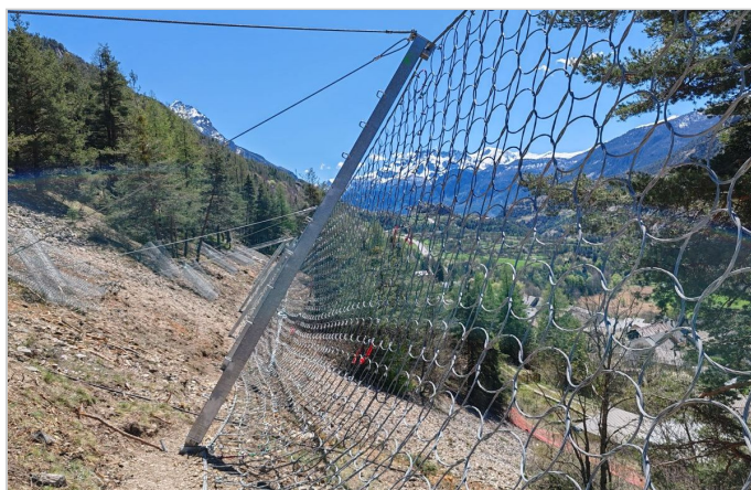
Poteaux équipés de marches
