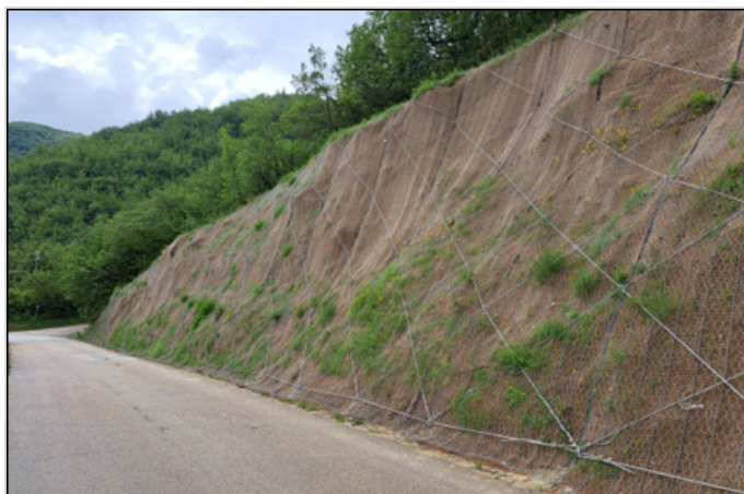
Intervento di rafforzamento corticale con Steelgrid HR 30 BIO
