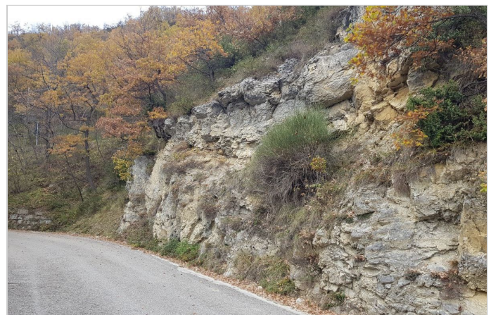
Vista scarpata oggetto di intervento
