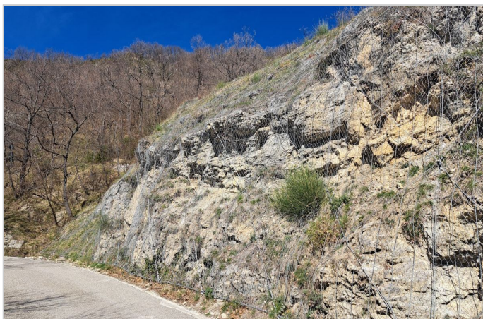
Intervento di rafforzamento corticale con Steelgrid HR 30
