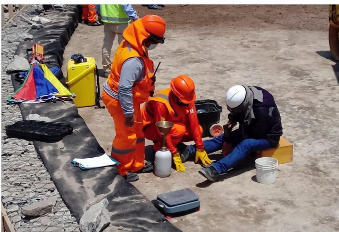
Durante la Obra
