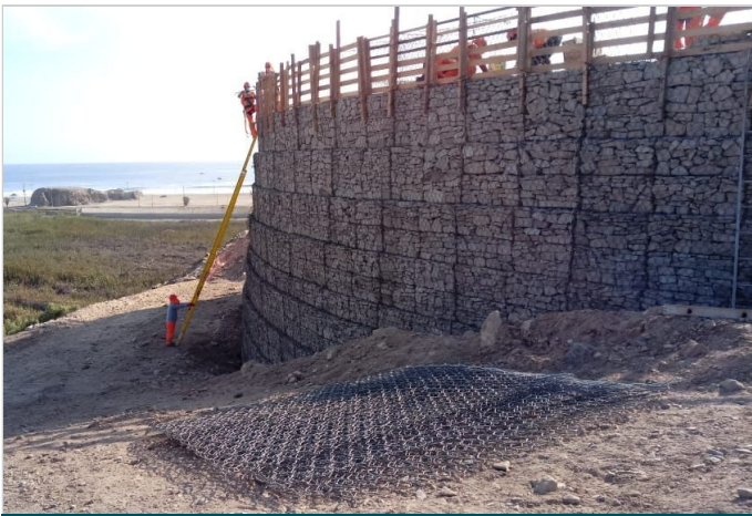
Durante la Obra
