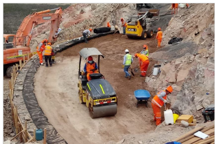
Durante la Obra
