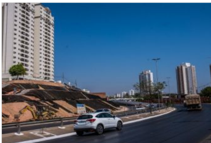
Durante a obra
