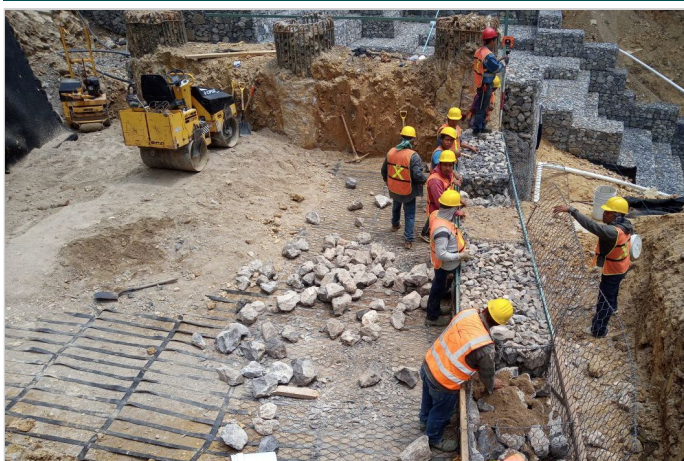
Durante la Obra
