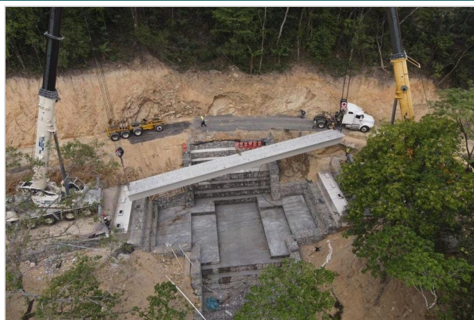
Durante la Obra
