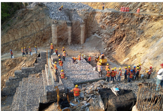
Durante la Obra
